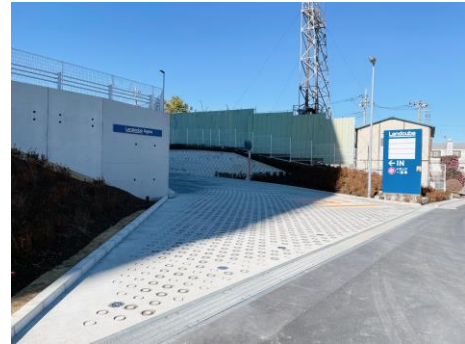
③東側車両出入口
