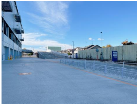
②敷地内車路
